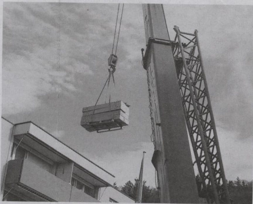
Mit diesem Kran wurde das Material transportiert.
