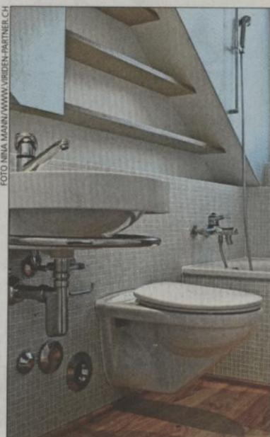
Perfekt bis ins Detail: Einhebelsmischer mit Eco-Funktion und Durchflussbegrenzer im Lavabo und Sparbrause zum Duschen
