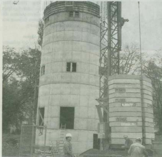
Der für das Pelletierwerk erstellte Turm.
